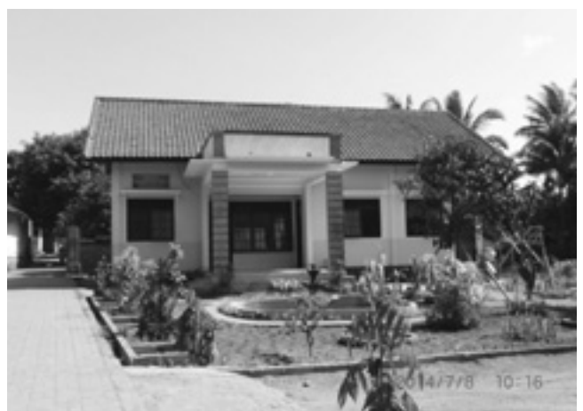
写真21 新校舎完成 (2014年7月)
