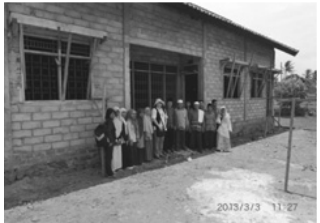
写真20 Takako基金とGotong Royongによる新校舎建設中 (2013年3月)
